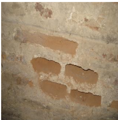
Fig. 7. Breking bricks
